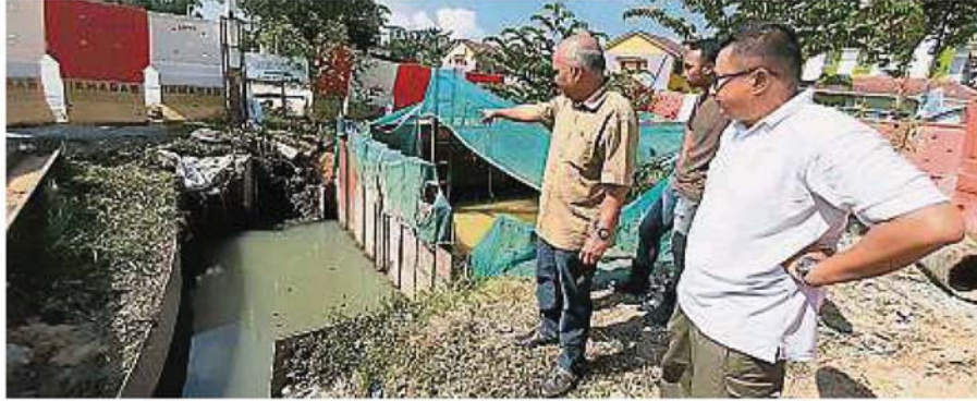
管工程地点出现积水的问题。陪同视察冷岳2滤水站净水管输送刘佳达(右)在承包商代表
